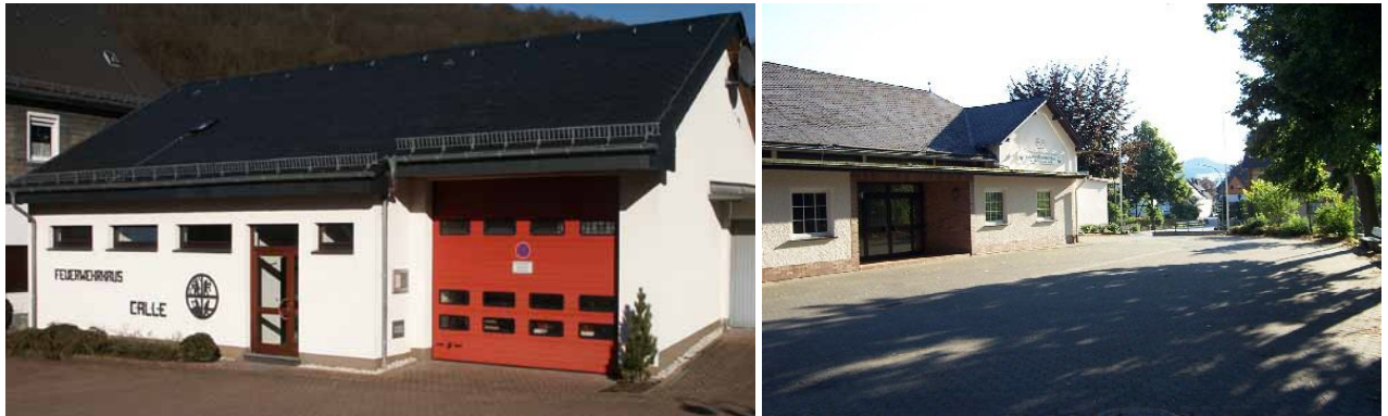
Abbildung 5: Fotoaufnahme Feuerwehrgerätehaus und Schützenhalle
